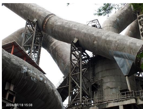
รูปที่ 2-27 ท่อนำลมร้อนทิ้งจาก P/H Boiler และ Clinker Cooler โรงงาน 3 (สายการผลิตที่ 5 และ 6)
