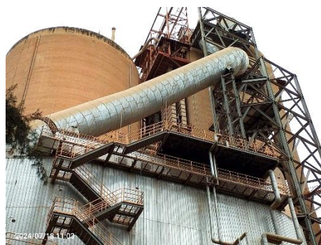
รูปที่ 2-27 ท่อนำลมร้อนทิ้งจาก P/H Boiler และ Clinker Cooler โรงงาน 3 (สายการผลิตที่ 5 และ 6)
