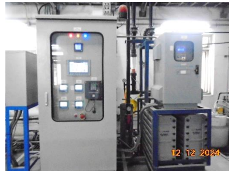
รูปที่ 2-39 ระบบ EDI (Electrodeionization)
