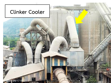
รูปที่ 2-3 ท่อนำลมร้อนทิ้งจาก P/H Boiler และ Clinker Cooler โรงงาน 2 (สายการผลิตที่ 3)
